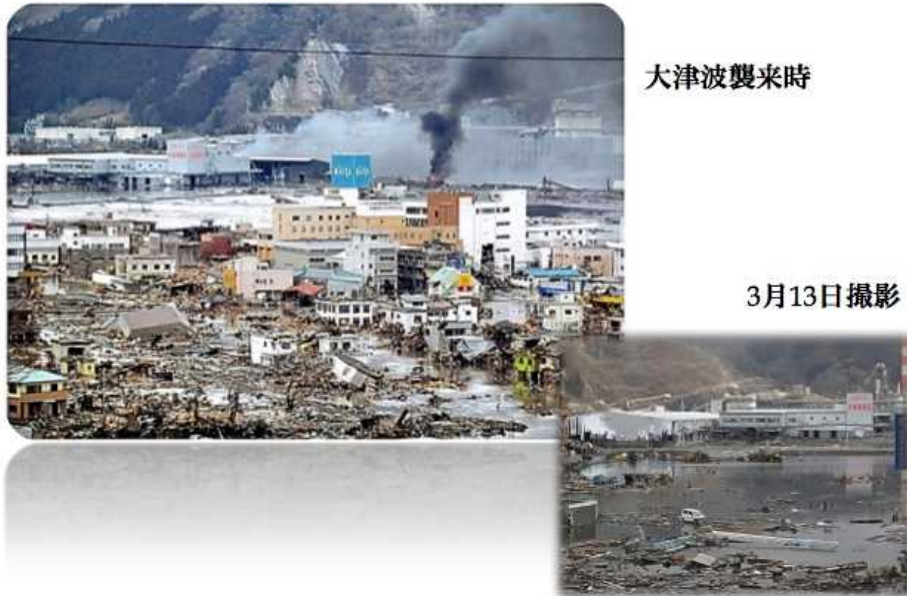
図6. 2011年3月11日の津波襲来時およびその後の様子
