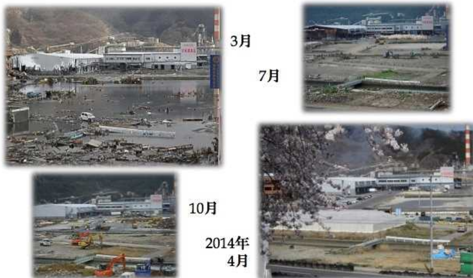
図 8. 工場復旧工事の進行
