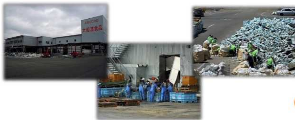
図 7. 各工場の復旧工事
